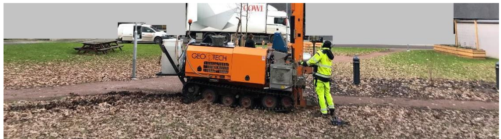
Figur 5: Provtagning med skruvborring i den så kallade Garnisonsparken mellan Polismyndigheten och Rättscentrum Göteborg, punkt CWM07.
